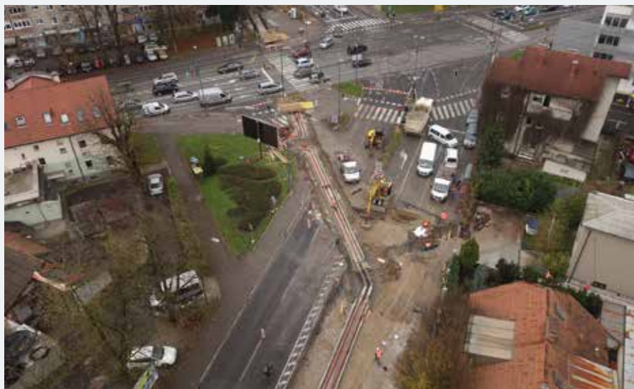
Prenova Drenikove ulice je posneta z dronom.
